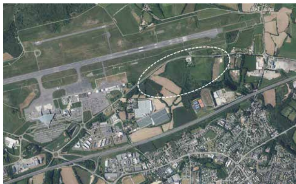
Kernoas, au sud-est des pistes de l'aéroport Brest-Bretagne
