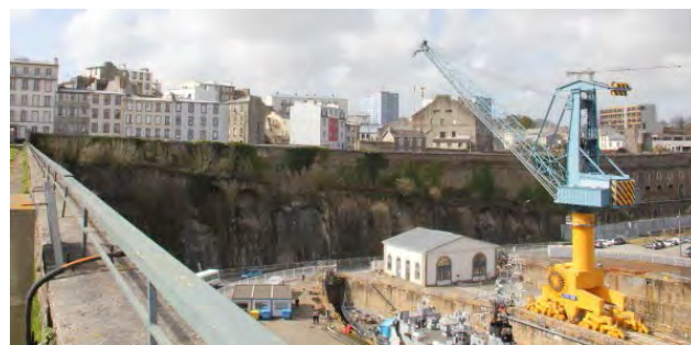
Rampe de Pontaniou
