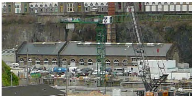
Bâtiment des forges
