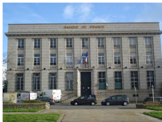
Banque de France Adresse : 39 rue du Château Référence cadastrale : KO 40
