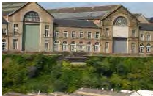
Bâtiment dit « Toilettes chinoises » Adresse : 119P route de la Corniche Référence cadastrale : IR49
