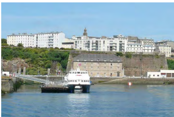
Bâtiment des subsistances
