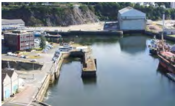
Demi-forme de radoub du Salou (bassin n°6)
