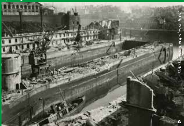
A. Les formes de radoub en 1944 au sortir de la guerre. B. En contrebas des Ateliers, le bâtiment aux lions, rare exemple d'édifice-pont.
