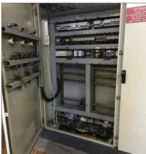
Dépose des démarreurs électriques
