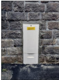
Mise en place d'un Inverseur de source manuel pour groupe électrogène mobile
