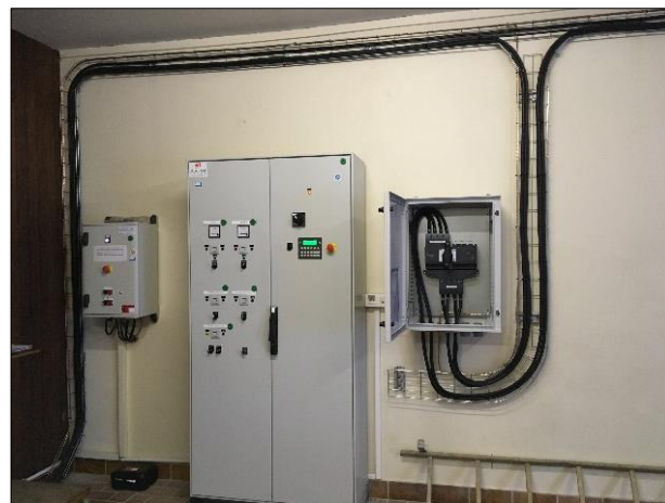
Mise en place d'un Inverseur de source manuel pour groupe électrogène mobile
