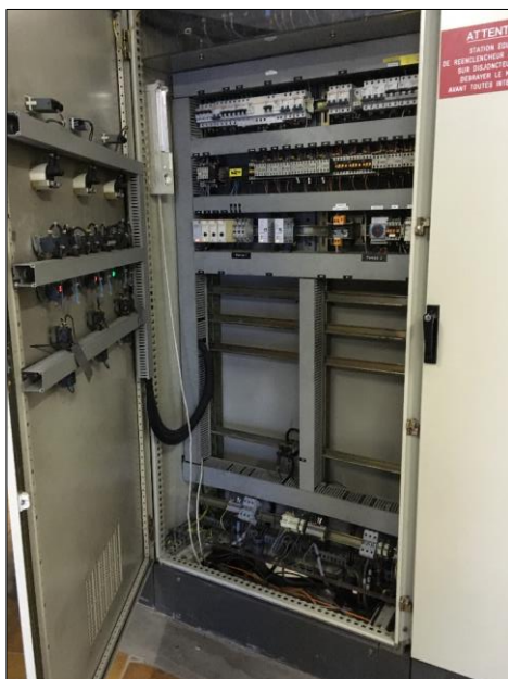
Dépose des démarreurs électriques
