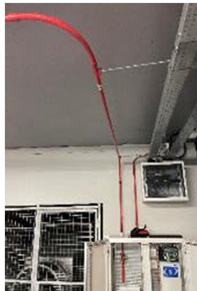
Ligne de détection comportant des trous de 2 à 4 mm pour les plus éloignés du coffret et détecteur
