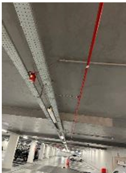
Ligne de détection comportant des trous de 2 à 4 mm pour les plus éloignés du coffret et détecteur
