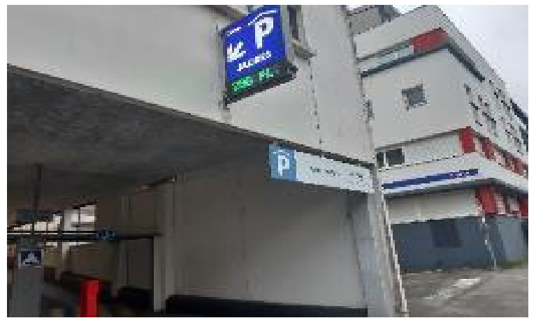
Entrée Parking Jaurès
