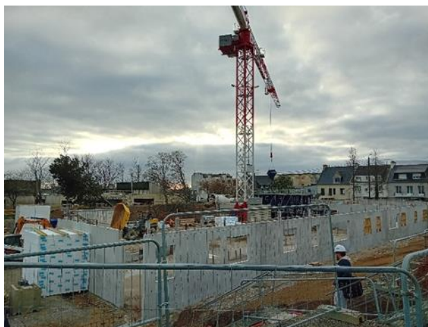
École Kérisbian – Terrassement et gros-œuvre
