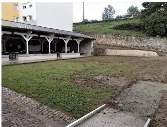
Travaux de sécurisation - Lavoir Saint-Malo
