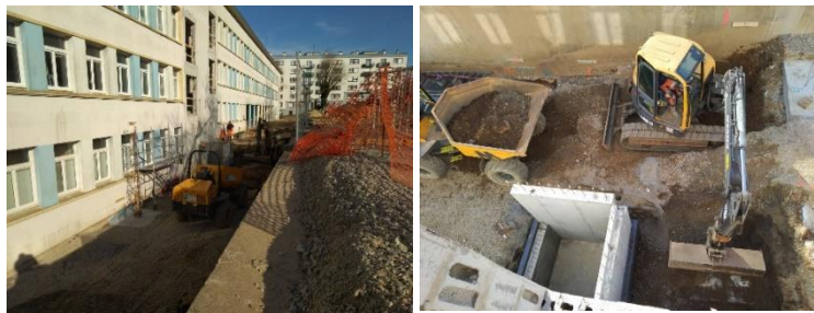
Maison des associations – terrassement
