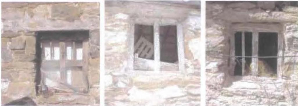
Diversité de fenêtres anciennes, composées de meneaux (verticaux et horizontaux) et de barreaux de bois. Certaines menuiseries très bien réalisées possèdent des volets intérieurs à bourdon (photo en haut à droite).
