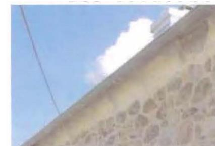
La corniche est enduite d'un mortier de chaux. Cet enduit couvre la maçonnerie et le bout des corbeaux.
