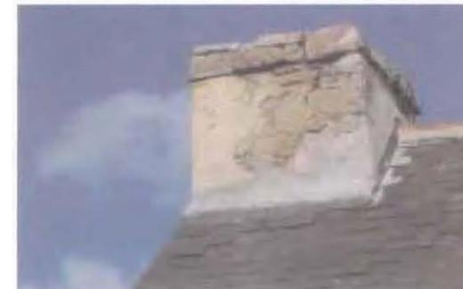
La souche de cheminée typique de Plougastel. De plan rectangulaire, au milieu du faîtage, elle possède un couronnement en pierre soutenu par une rangée d'ardoises. On observe ici des restes d'enduits à la chaux sur sa gauche.
