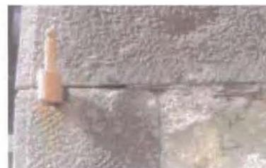
La lecture de la maçonnerie est indispensable pour comprendre la logique de la construction et réaliser ainsi des reprises harmonieuses. Dans la maçonnerie traditionnelle, le mortier de pose est d'épaisseur la plus faible possible. La solidité est apportée par la disposition des pierres entre elles, fruit du savoir-faire du maçon. Si une reprise de maçonnerie diffère techniquement de la maçonnerie du reste du mur, la reprise restera toujours visible.
