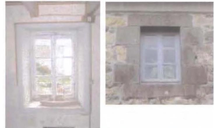
Menuiseries de la fin du XIX<sup>ème</sup> et du XX<sup>ème</sup> siècle. Des fenêtres à six carreaux. Le système de fermeture est assuré par une barre sur pivot.
