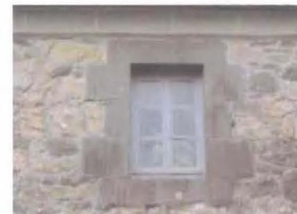
Encadrement de la fenêtre en kersanton et quelques moellons de Logonna dans la maçonnerie
