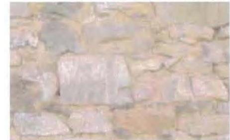
Mur de grès quartzite maçonné au mortier de terre
