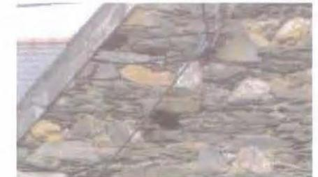
Maçonnerie de schiste avec quelques moellons de quartz en blanc et de grès quartzite
