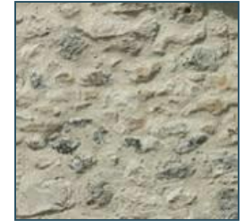
Exemple d'enduit à pierre-vue
