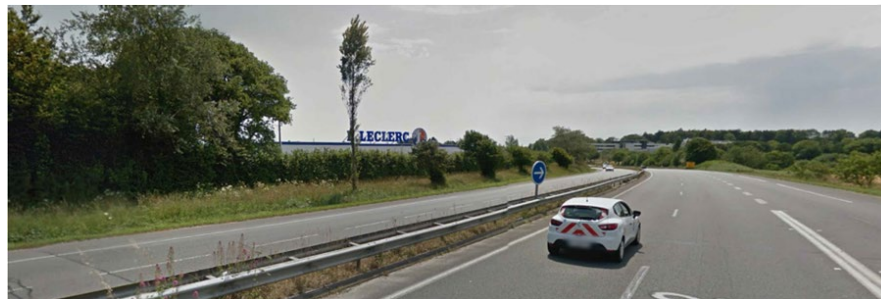
Vue de l'existant
