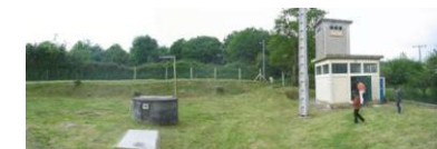
Captage de Kergonnec
