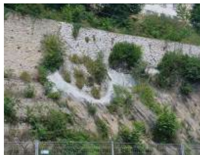
Falaises sécurisées de Poulic al Lor Source : CU
