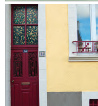
Façade D2, soubassement F2, encadrement des ouvertures en blanc, porte, garde-corps et châssis soupiraux G12.
