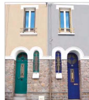
Maçonnerie A4, modénatures blanches, ferronneries RAL 1019, porte et fenêtre RDC C25 et lavage du soubassement.
