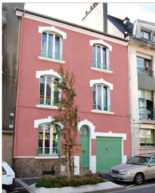
Cette teinte saturée de façade a été retrouvée sous les couches successives de peinture (façade E8, modénatures blanches, ferronneries et portes C32).
