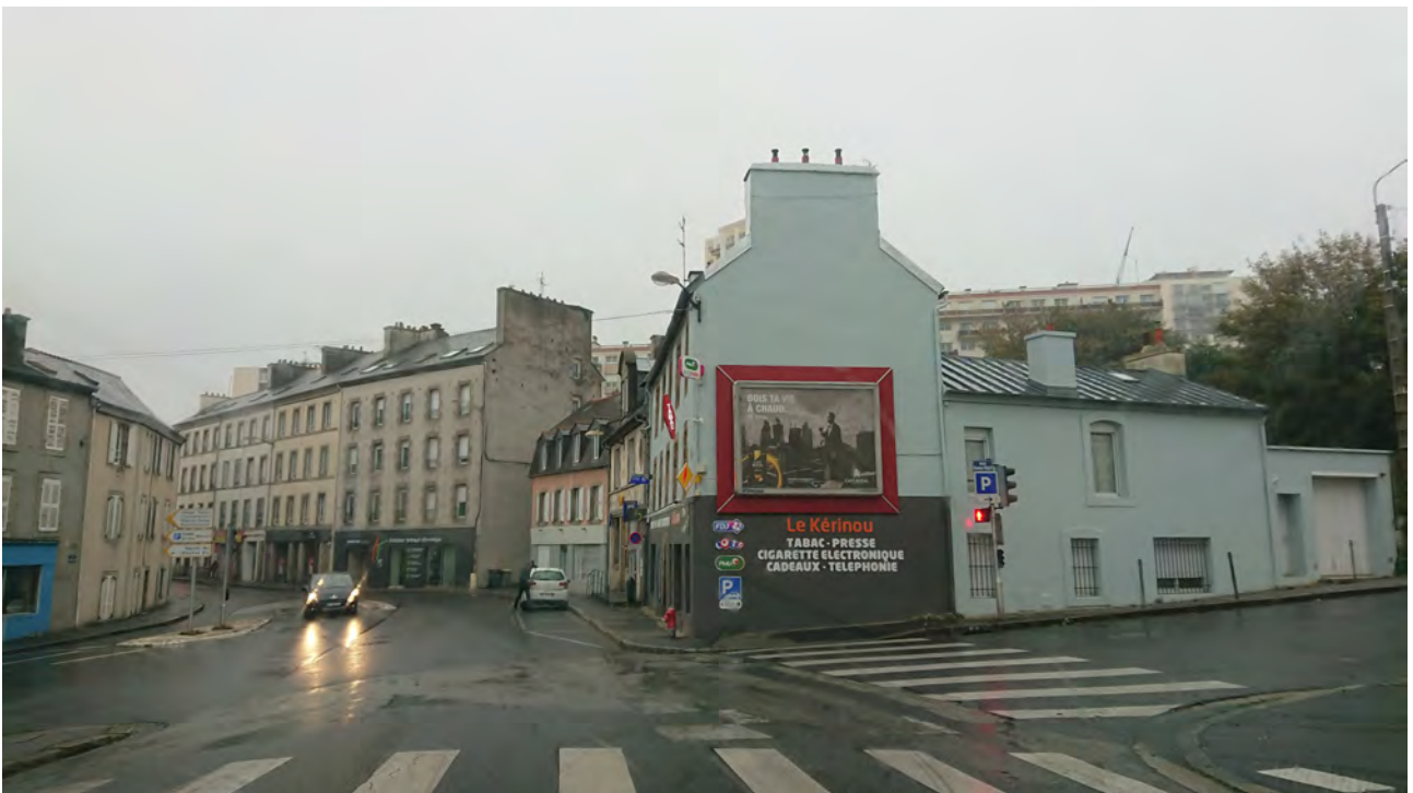
Rue Auguste Kervern à Brest – Après ravalement de façade © Brest métropole
